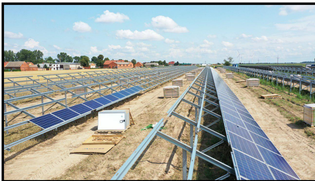
Zdjęcie 3 Konstrukcja wsporcza (farma słoneczna Ziemiń, gm. Krobia)
