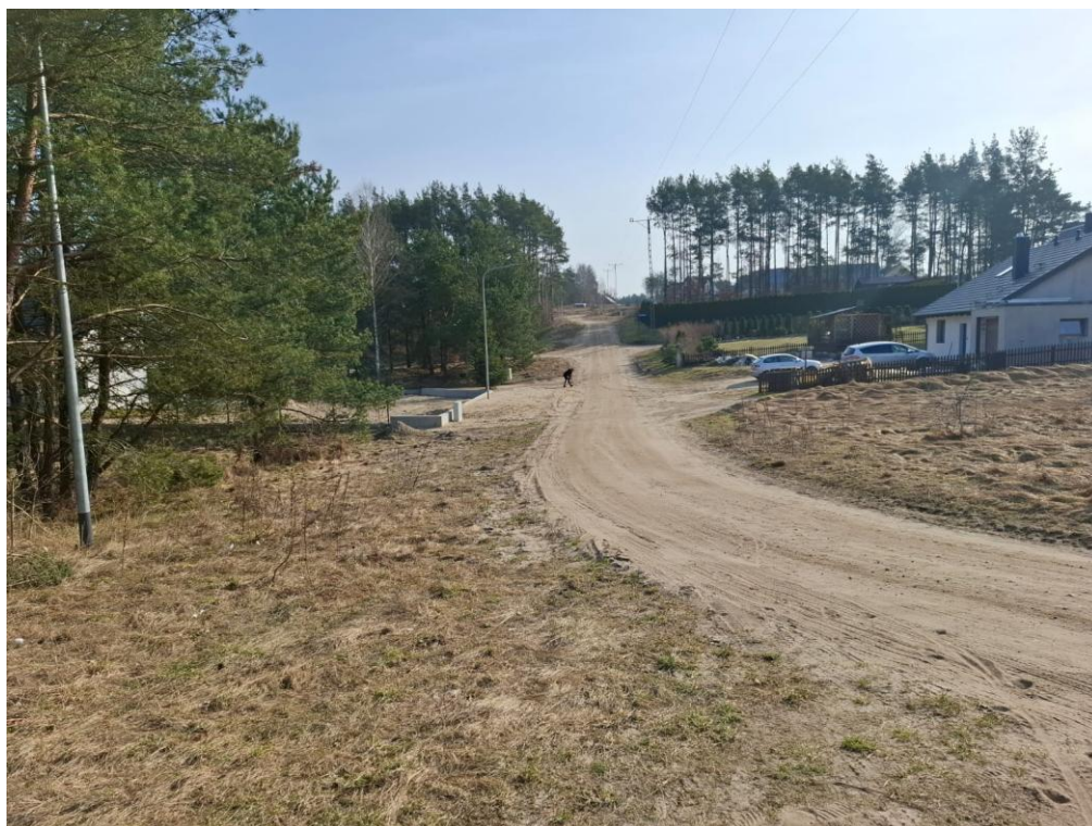
Fot. 6 Widok na teren planowanego przedsięwzięcia – fragment ul. Pogodnej ze skrzyżowaniami z ul. Radosną i w oddali z ul. Polną
