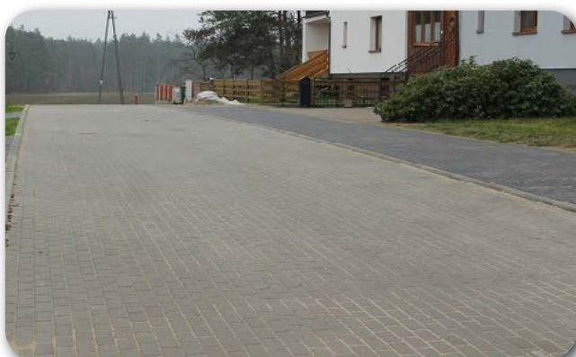
Przebudowa ul. Wrzosowej w Studzienicach
