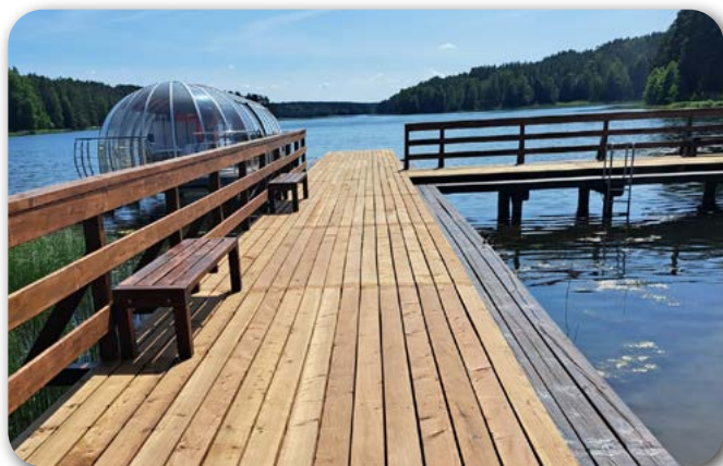
Remont pomostu w Studzienicach
