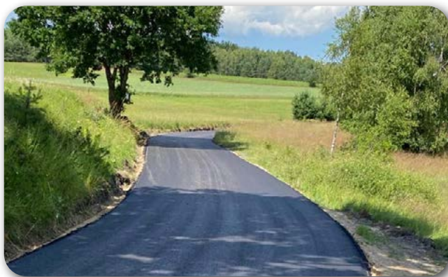
Budowa drogi gminnej łączącej Ugoszcz-Grand
