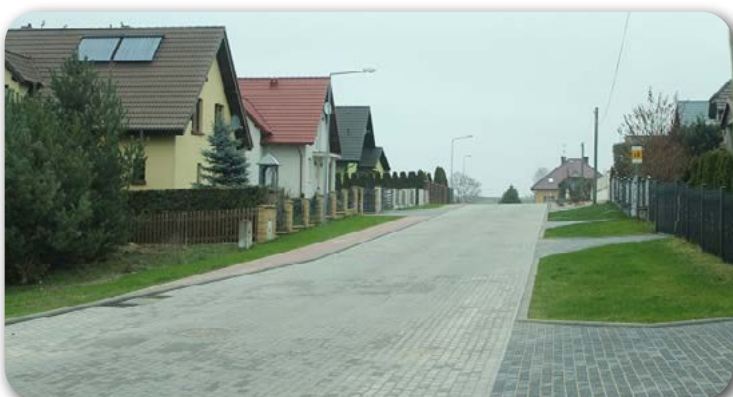
Przebudowa ul. Lawendowej w Półcnie
