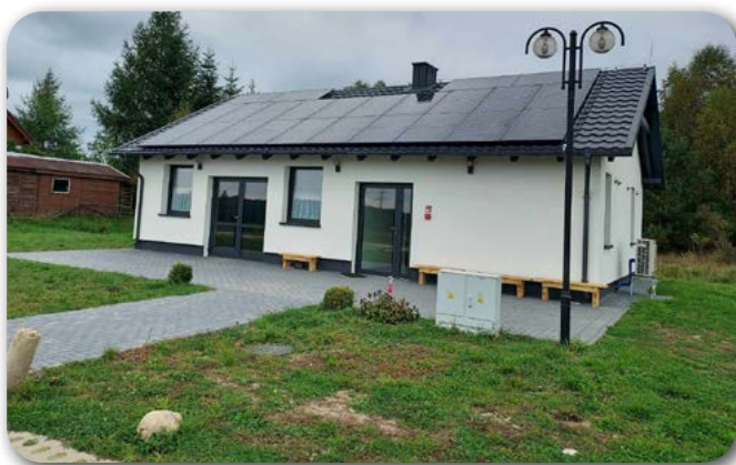
Dostawa i montaż instalacji fotowoltaicznej na budynku Świetlicy Wiejskiej w Rabacinie
