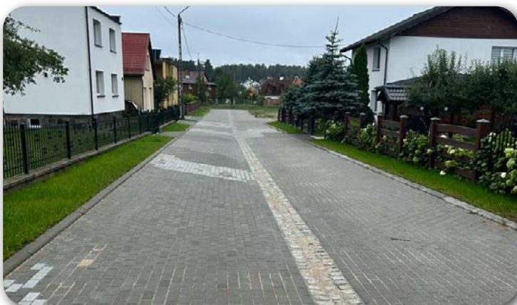
Przebudowa ul. Klonowej w Studzienicach
