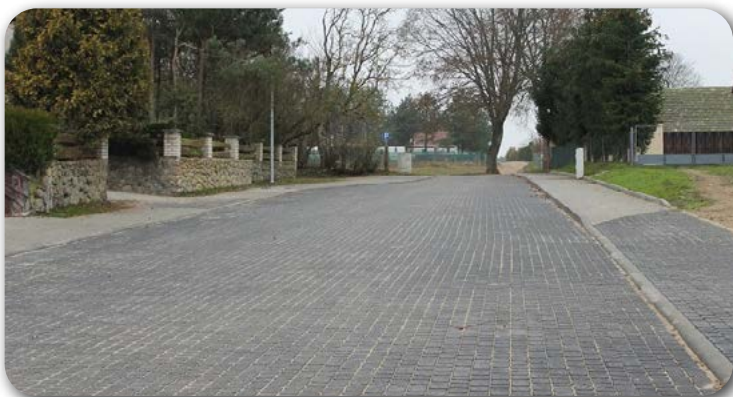
Przebudowa ul. Wczasowej w Kłęcznie
